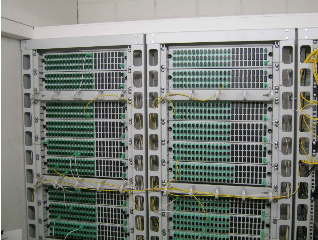
Oben: Teil der Patchfelder einer Open-Access-Glasverkabelung, Baujahr 2016
